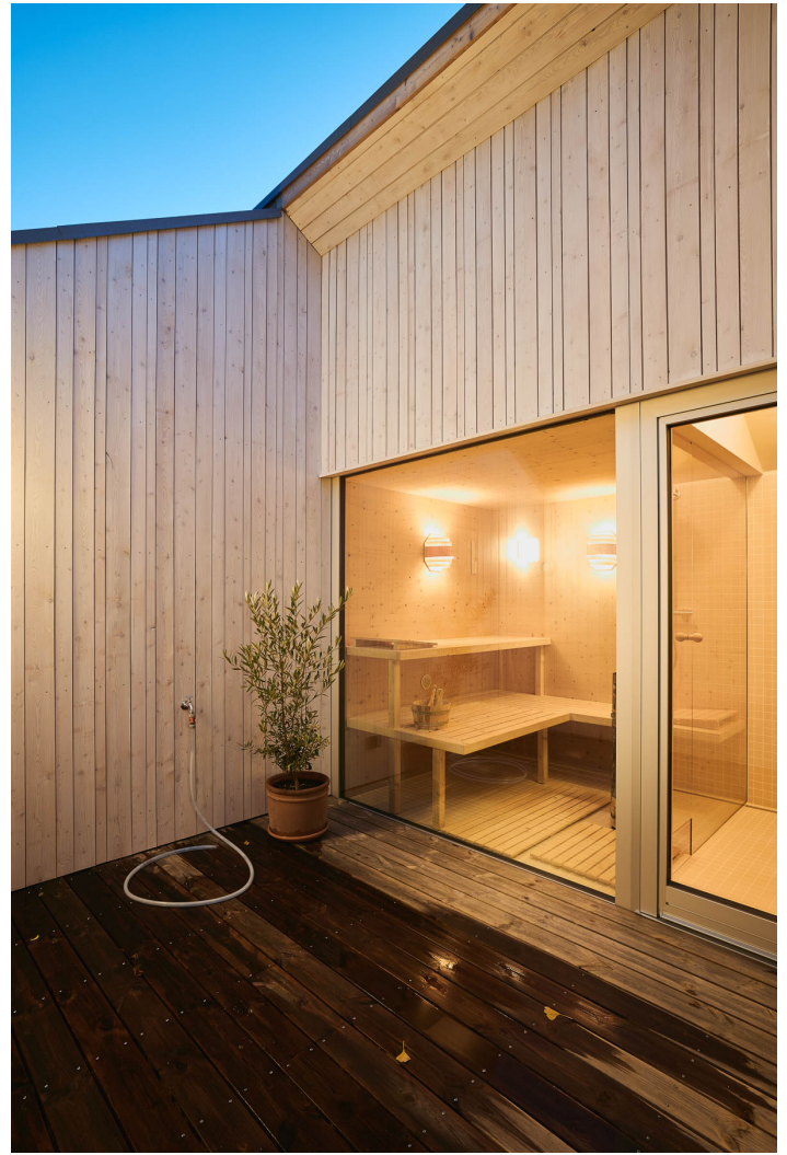
Durch das Versetzen einer Dachhälfte entsteht ein geschützter Außenbereich. © Constantin Riess
